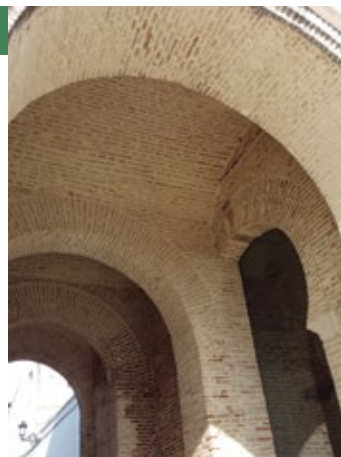
Interior del Arco de la Pescadería (imagen: Ayto. de Aznalcázar).
